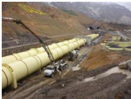
شکل ۴- (نمایی از بتن ریزی انکر بلاک)
