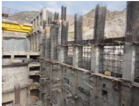
شکل ۸- (نمایی از اجرای بتن ریزی از ارتفاع ۳,۵ متر)
