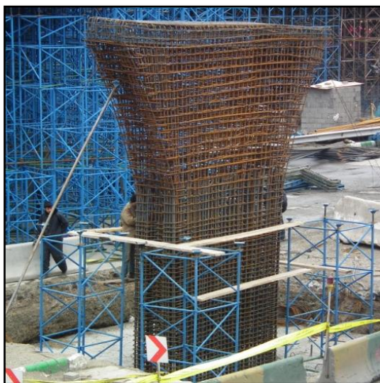
شکل ۱- تراکم آرماتور و ارتفاع پایه های پل تقاطع غیر همسطح شاهد
