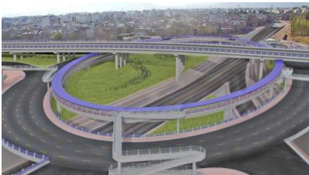
شکل ۱- نمای ۳ بعدی پروژه مورد مطالعه (عرشه رینگ بیضی شکل دور میدان از شاهتیرهای جعبه‌ای ساخته شده است)
