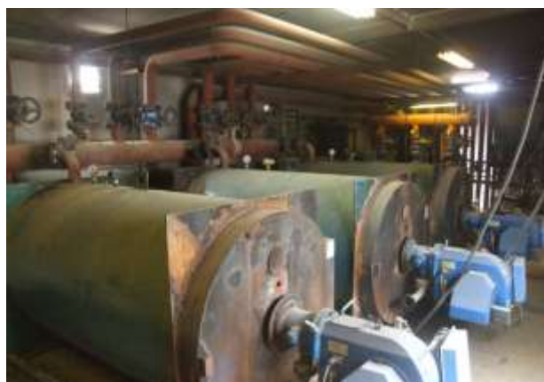
شکل ۴- موتورخانه تامین آب گرم برای عمل آوری بتن
