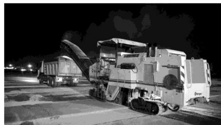
(۱) برداشت سطح هوازده دال بتنی
