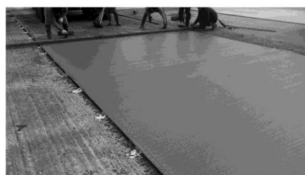
(۳) اجرای رویه ترمیمی با ملات اصلاح شده پلیمری
