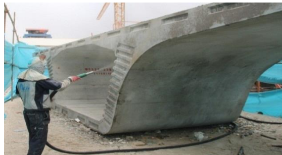
شکل ۷- ماسه پاشی و نظافت قطعات (سمت راست) و اسپری مواد محافظ نمای بتن (سمت چپ)
