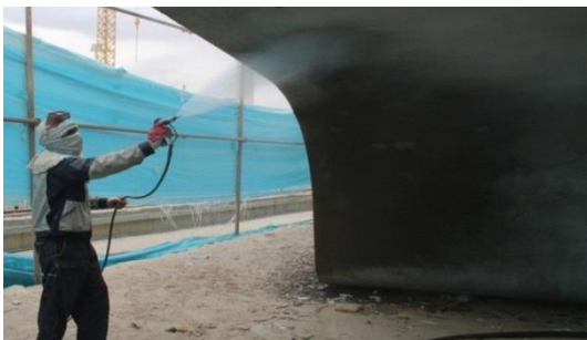
شکل ۷- ماسه پاشی و نظافت قطعات (سمت راست) و اسپری مواد محافظ نمای بتن (سمت چپ)
