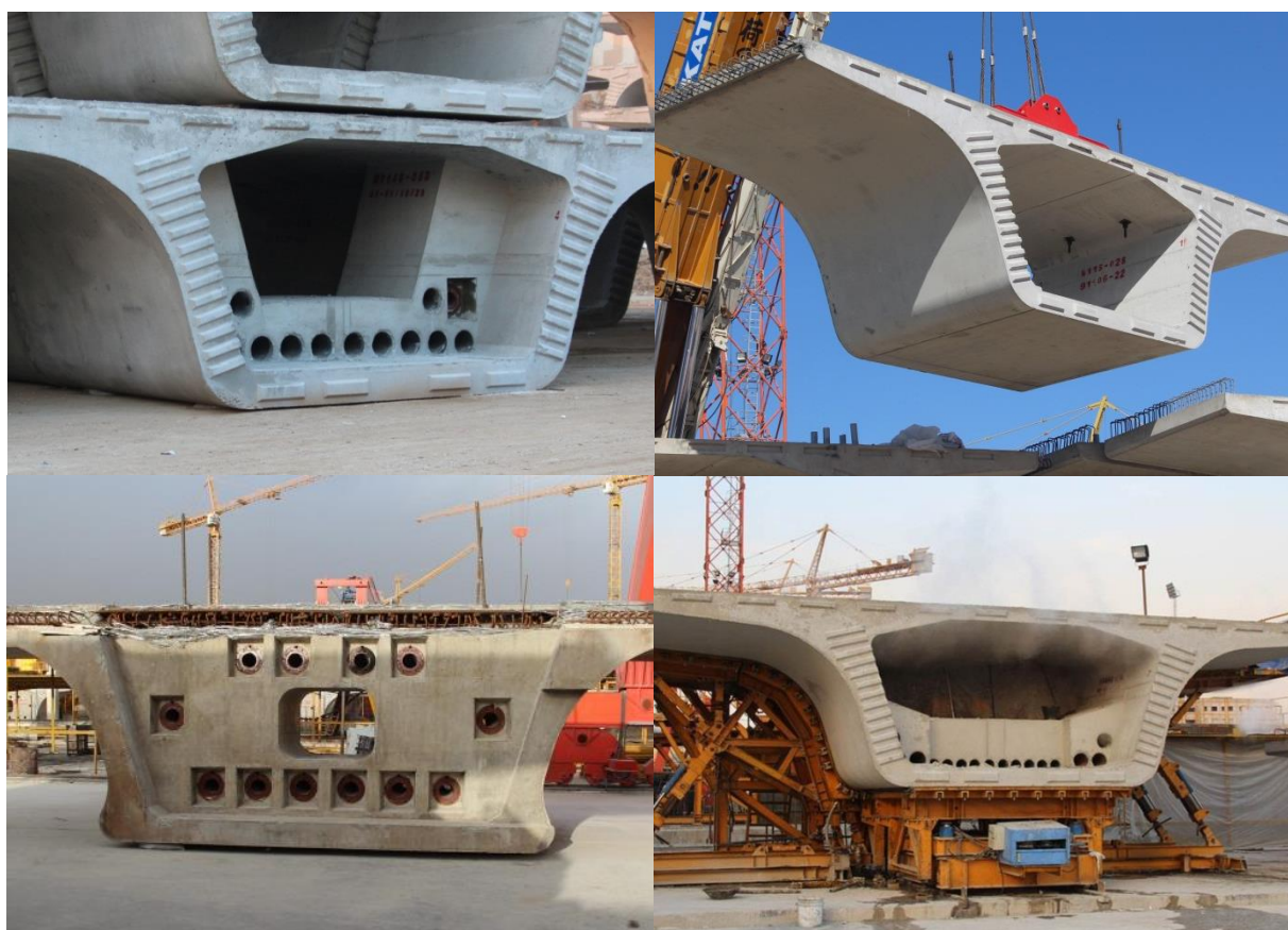
شکل ۳- قطعات سگمنت تولید شده برای عرشه اصلی پروژه بزرگراه طبقاتی شهید صدر
