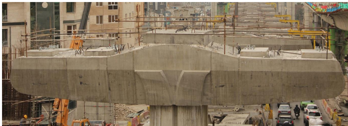
شکل ۲- قطعات سگمنتال سرستون نصب شده در محور پروژه
