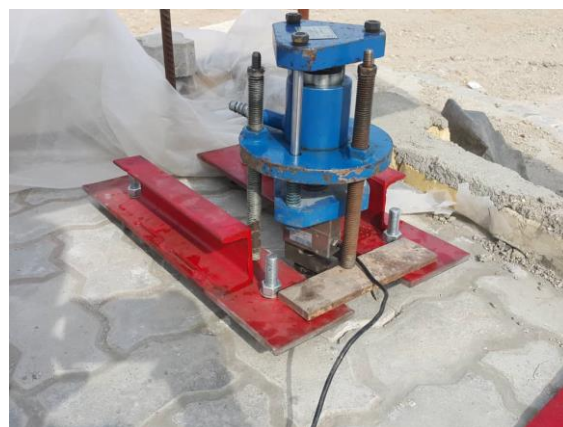
شکل ۹- انجام آزمایش Pull-off بر روی بلوک های بتنی
