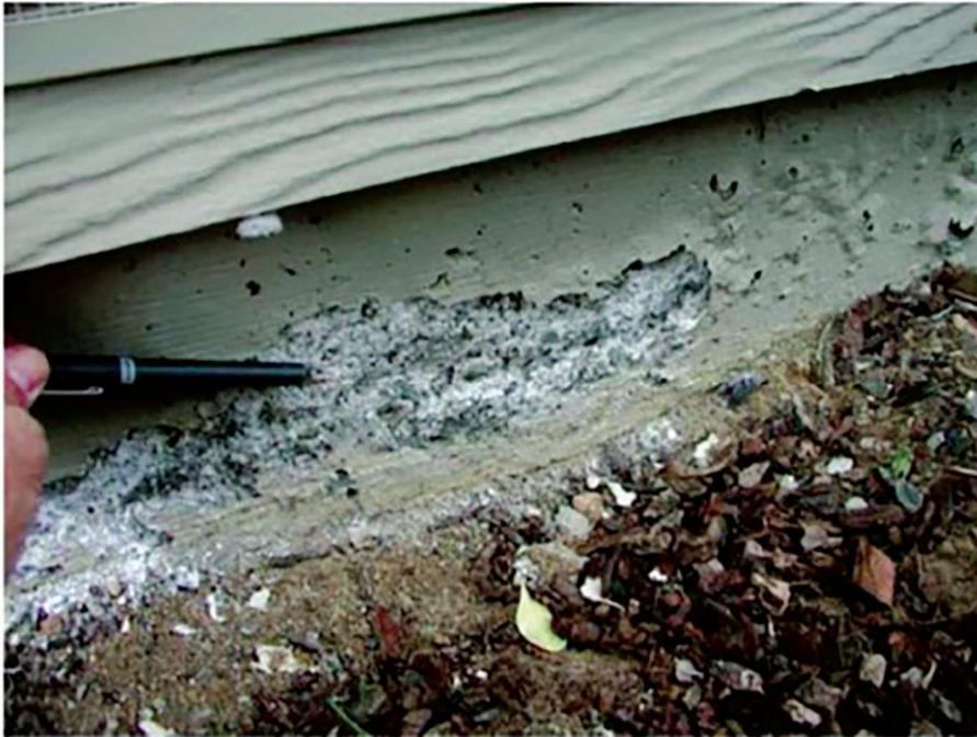
شکل ۸-۱ الف. حمله فیزیکی نمک به شالوده بتنی ساختمان مسکونی. پوسته شدن سطح بتن ناشی از سدیم سولفات موجود در آب منفذی خاک می‌باشد. نمک در پشت یک پوشش رنگ روی پانچور دیوار انباشته شده است (Bassuoni و Haynes، ۲۰۱۱).
