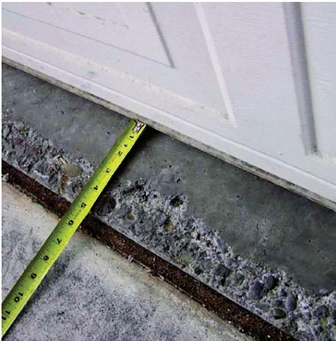
شکل ۸-۱ ب. حمله فیزیکی نمک ناشی از سدیم کربنات به دال بتنی پارکینگ. پوسته شدن در امتداد جبهه تبخیر رخ داده است (Bassuoni و Haynes، ۲۰۱۱).
