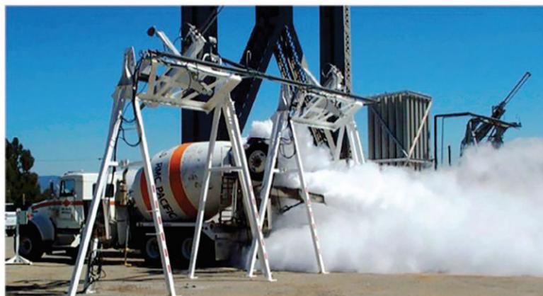
شکل ۵-۷-پ- سرمایش بتن پیمانه شده از طریق تزریق نیتروژن مایع
