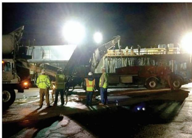
شکل ۵-۳-ب- (الف) ریختن بتن حجیم توسط نوار نقاله در یک بتن‌ریزی بتن حجیم متعارف؛ و (ب) در یک بتن‌ریزی بتن حجیم با کنترل حرارتی.
