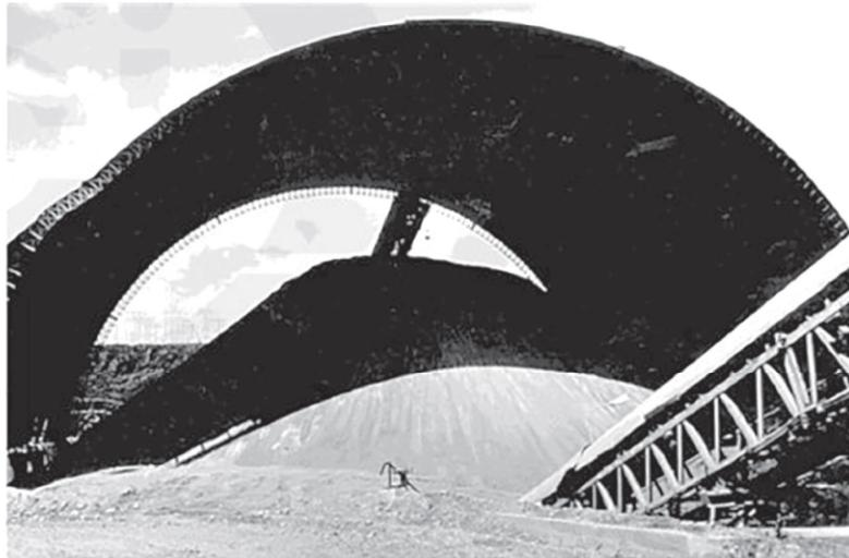
شکل ۵-۷-الف- پوشش فلزی در بالای اباشته سنگدانه ریز زهکشی شده برای کاهش جذب گرما
