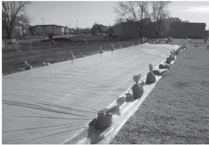
شکل ۸-۶-ب- استفاده از کیسه‌های ماسه برای ثابت نگه‌داشتن پوشش نایلونی عمل‌آوری (عکس از J. Kevern)
