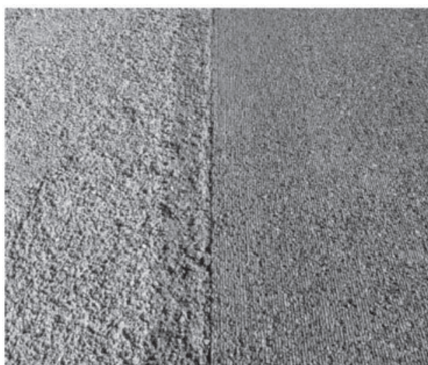
شکل ۱۰-۷-۱- خراشیدن سطح روسازی تراوا برای ترمیم واچیدگی سطحی
