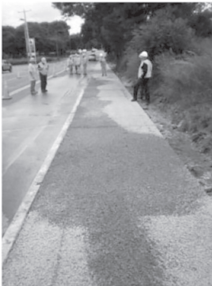
شکل ۳-۳-۳- شانه بتنی تراوا به منظور کنترل سیلاب
