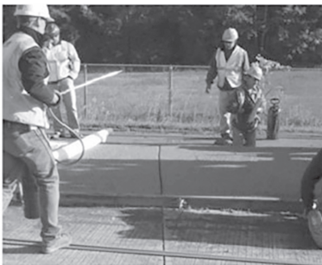
شکل ۱۰-۹- ریختن روکش بتنی تراوا به منظور کاهش صدا و افزایش مقاومت لغزشی روسازی
