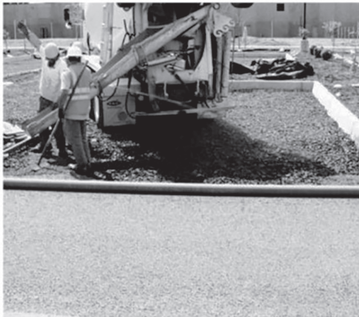
شکل ۸-۳-۲-الف- ریختن بتن تراوا توسط تخلیه از ناوه کامیون مخلوط کن (عکس از S. Erickson)
