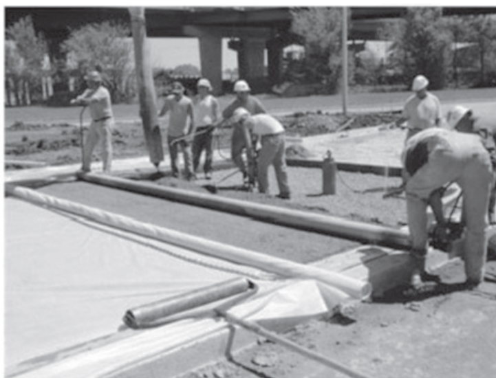
شکل ۸-۶-الف - عمل آوری با استفاده از لایه نایلونی بلافاصله پس از تراکم (عکس از C. Martin)
