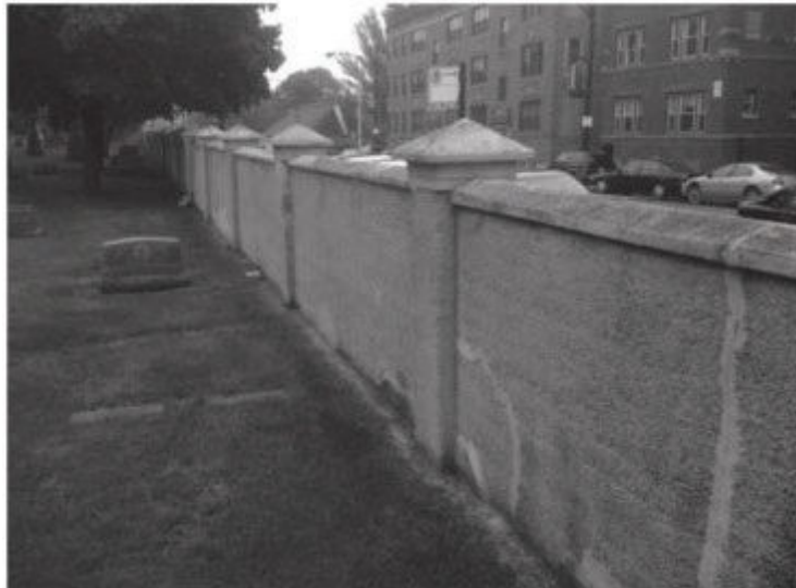
شکل ۳-۲- دیوارهای بتنی تراوای مسلح که در اوایل قرن بیستم ساخته شده‌اند (عکس از G.Segebrecht)
