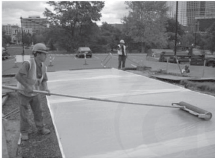
شکل ۸-۳-۴- پرداخت سطح بتن تراوا با استفاده از شمشه غلتان در جهت عرضی (عکس از B. Banka)
