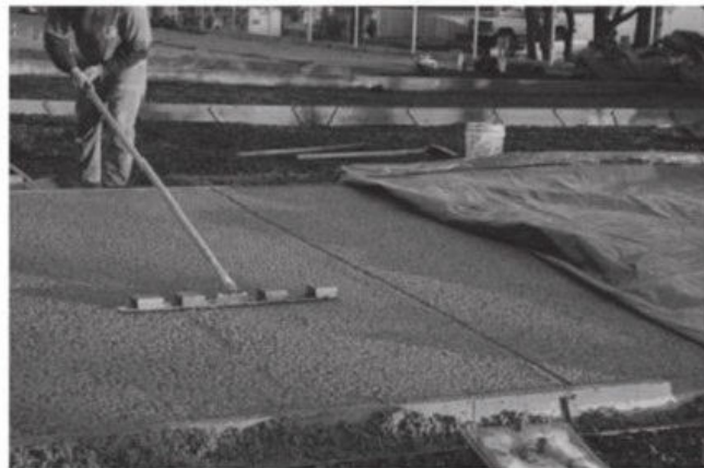
شکل ۸-۴-۲-الف- نمونه استفاده از ماله فرز نوئی سنگین برای تصحیح آثار به جا مانده از شمشه‌کشی عرضی
