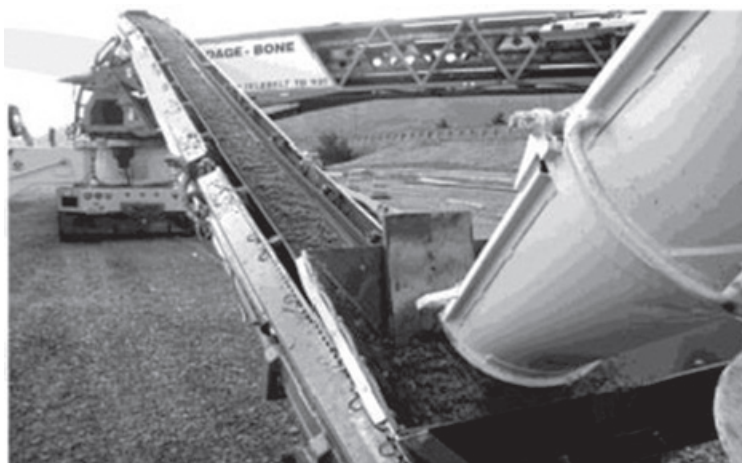
شکل ۸-۳-۲-ب- استفاده از تسمه نقاله برای ریختن بتن تراوا
