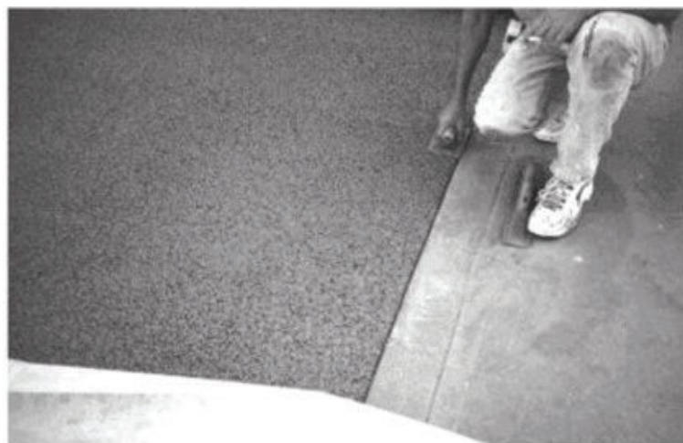
شکل ۸-۴-۲-ب- لبه‌سازی بتن تراوا (عکس از M. Offenber)
