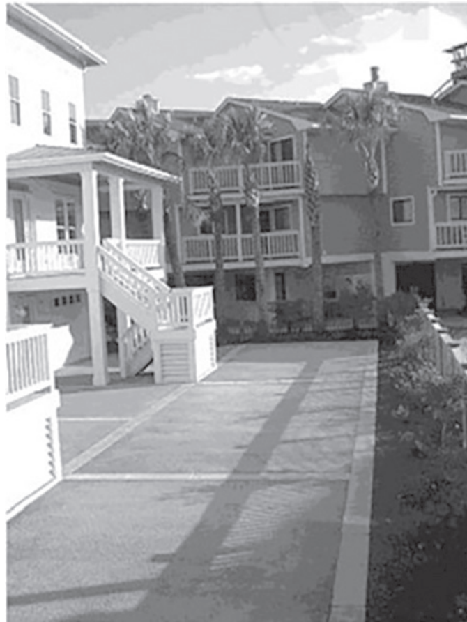
شکل ۳-۱- روسازی پارکینگ ساخته‌شده با روسازی بتنی تراوا
