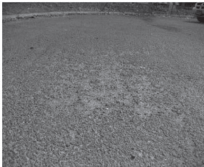
شکل ۱۰-۴- واجیدگی سطحی بتن تراوا
