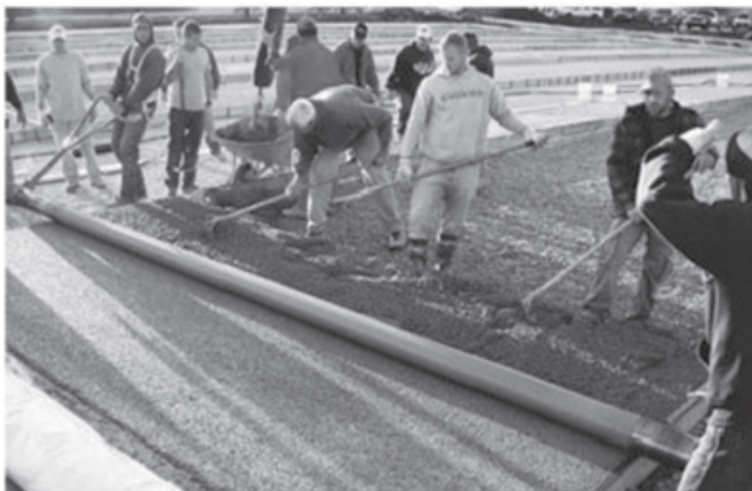
شکل ۸-۳-۲-پ- استفاده از شن کش برای رساندن تراز سطح بتن تراوا به تراز تقریبی (عکس از J. Kevern)
