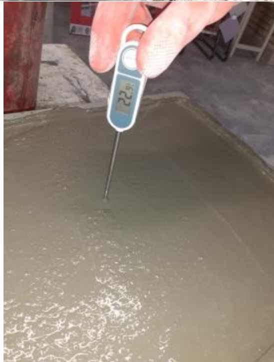
شکل ۶: ساخت آزمون های دال بتنی
