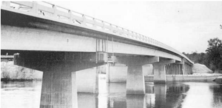
شکل ۷-۱۲-ب- بتن با وزن کمتر از 1920 \text{ kg/m}^3 ، استفاده از دهانه‌های 37 \text{ m} در پل فلوریدا را امکان‌پذیر کرد (Brown و همکاران، ۱۹۹۵).
