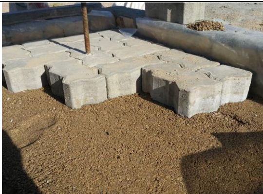
چینش بلوک های بتنی بر روی بستر ماسه ای: (۴)
