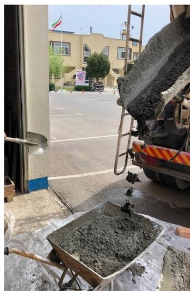
شکل ۱- نمونه‌گیری بتن تازه از کامیون حمل بتن
