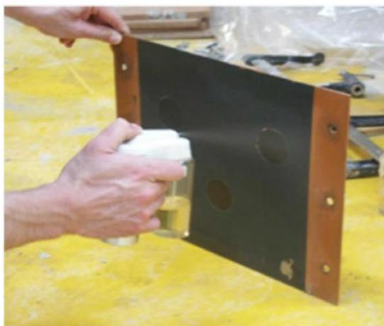
شکل ۱- اسپری کردن ماده رها ساز بر سطح قالب [۸]
