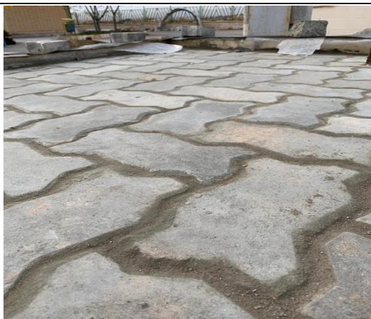
تکمیل ساخت روسازی با درزگیری نهایی سطح رویه: (۶)
