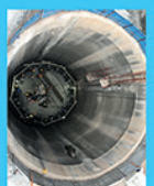
پوشش بتنی شفت (میله) آبگیر اصلی سد اردبیل
