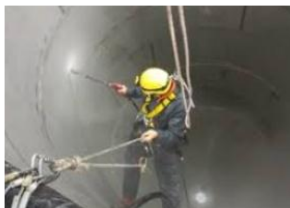
شکل ۱۱- تمیزکاری و تراشیدن دیواره داخلی سیلوی سیمان برای پیشگیری از مشکلات
