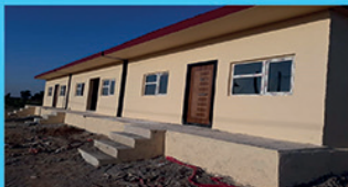
ساختمان پیش ساخته بتنی سریع الاجادات موسسه شهید رجایی
