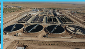
طرح، ساخت و بهره برداری تصفیه خانه فاضلاب شماره ۲ شهر تبریز
