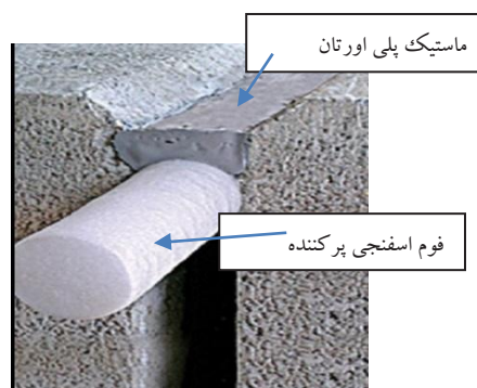
شکل ۶: درز بندی عمومی ژوئن های حرارتی (انبساطی)
