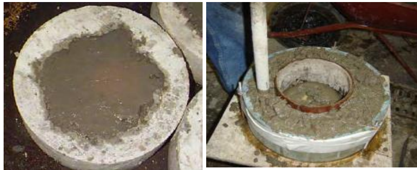
شکل ۵- اجرای ملات‌های ترمیمی بر روی بتن پایه
