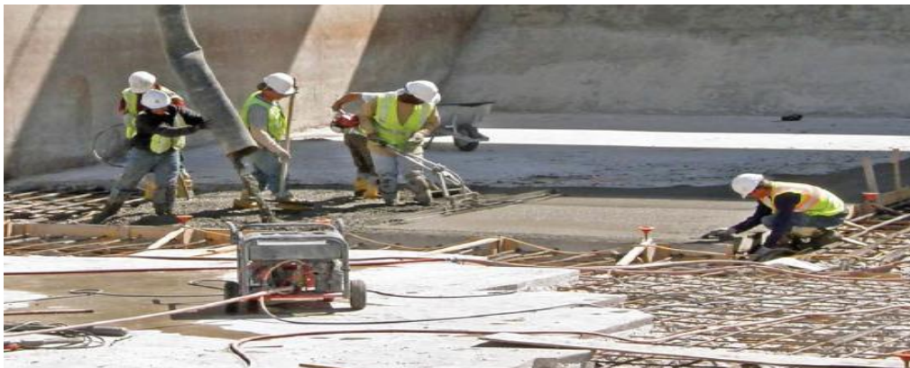
شکل ۶- اجرای ترمیم بتن آسیب دیده در سازه‌های هیدرولیکی
