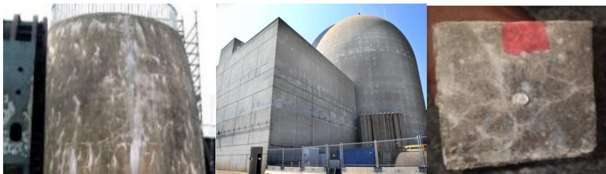
شکل ۱- ترک خوردگی سطحی و پاشیدگی ژل سفید رنگ بر اثر واکنش قلیایی - سیلیسی بر روی سطح بتن
