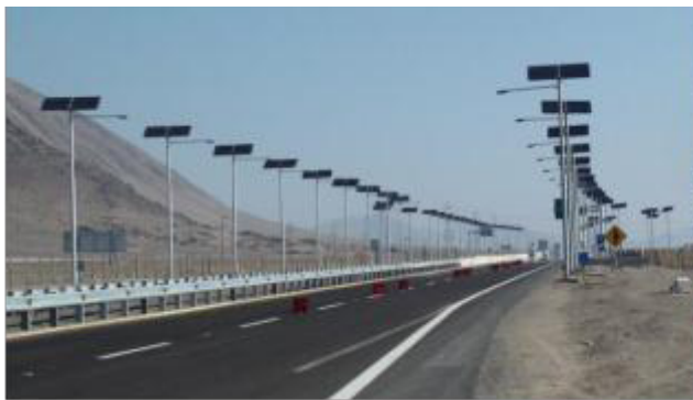
ب : نحوه قرارگیری پانل‌ها در کنار راه
