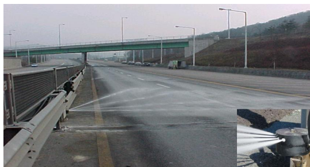
شکل ۲ روش هوشمند پخش مواد ضد یخ در سطح روسازی [۴]
