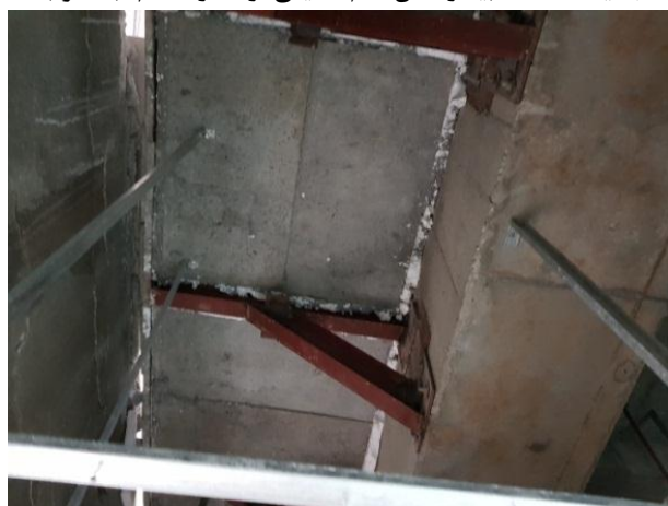
شکل ۴- عدم مشاهده خرابی ظاهری در تیرها و سقف‌های ساختمان جدید الاحداث بیمارستان امام خمینی (ره) در اسلام آباد غرب
