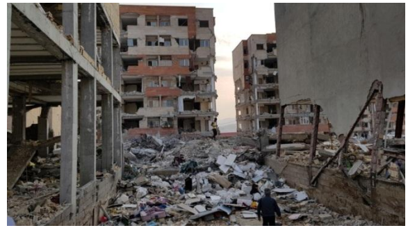
شکل ۱۰- تخریب گسترده در عناصر غیر سازه‌ای در ساختمان‌های اسکلت بتنی در مجموعه مسکن مهر شهید شیرودی در اسلام‌آباد غرب
