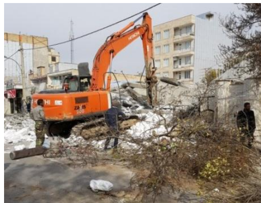
شکل ۱۴- ساختمان بتنی نیمه‌کاره فرو ریخته در اسلام آباد (ب)
