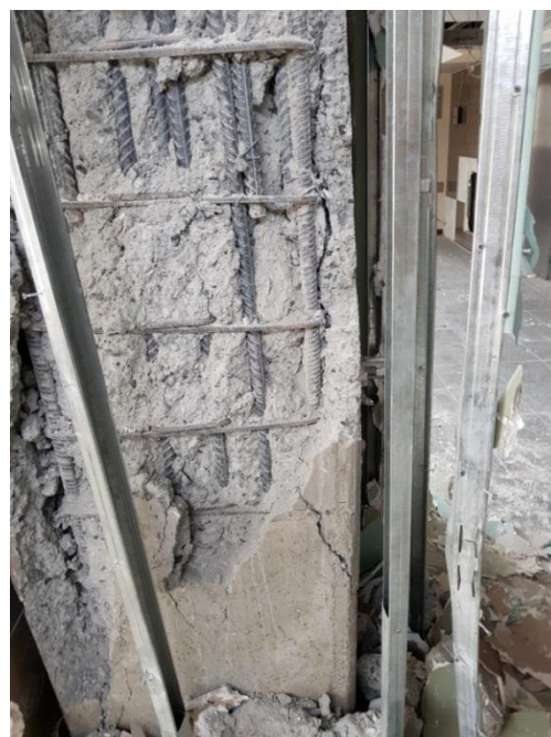
شکل ۳- گسیختگی بتن در یکی از ستون‌های طبقه پنجم ساختمان جدید الاحداث بیمارستان امام خمینی (ره) در اسلام آباد غرب
