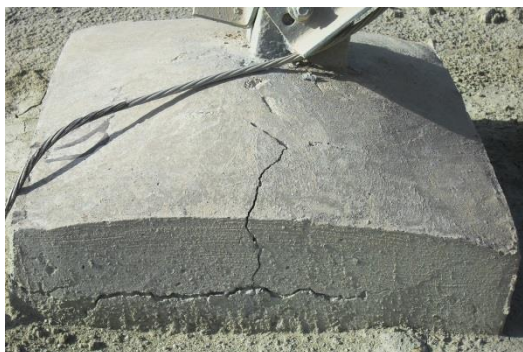
شکل ۲- تصاویر فونداسیون برج‌های انتقال (سمت چپ: دکل عبور از دریا در تنگه لافت، سمت راست: توسعه خوردگی)
