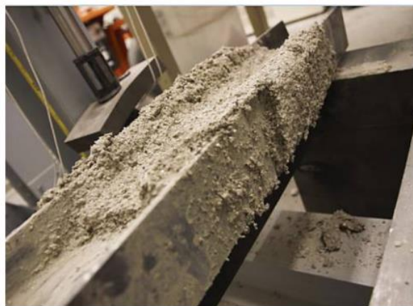
شکل ۱۴- نمای نزدیک خرابی SFRM بر روی بال پایینی تیر تحت ضربه
