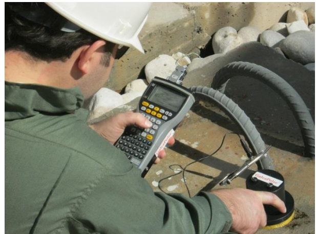
شکل ۳- استفاده از روش گالوانوستاتیک پالسی جهت تعیین سرعت خوردگی میلگرد داخل فونداسیون و مقاومت الکتریکی بتن
