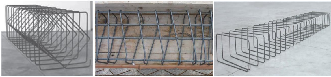
شکل ۳: خاموت پیوسته مستطیلی و چند ضلعی [۱].
