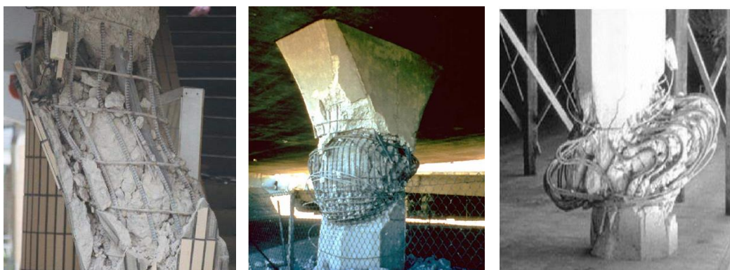
شکل ۲: آسیب های وارده بر ستون های بتن آرمه ناشی از خاموت گذاری نامناسب [۱].
