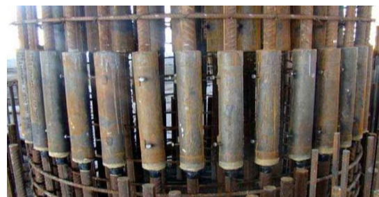
شکل (۱۹) - وصله تزریقی با گروت پر مقاومت
