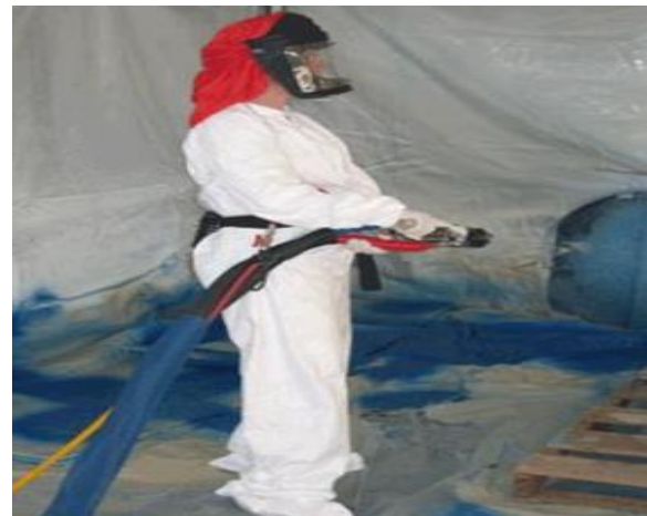
شکل ۸- استفاده از تجهیزات ایمنی
