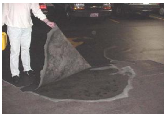
شکل ۱۴- گسیختگی عایق پلی اوره بدلیل عدم زیرسازی مناسب
