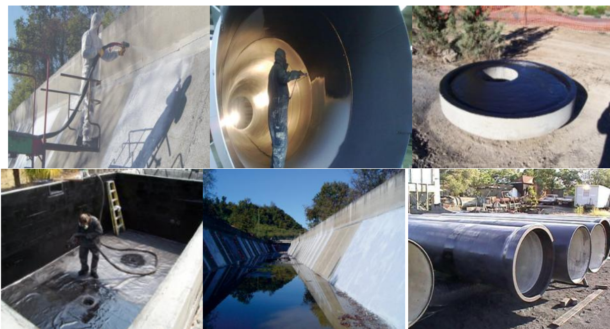
شکل ۱۱- استفاده از عایق پلی اوره در صنعت آب و فاضلاب
