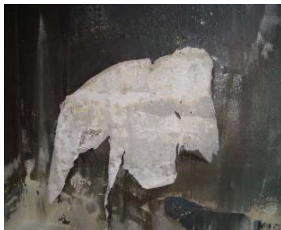
شکل ۱۵- گسیختگی عایق پلی اوره بدلیل عدم زیرسازی مناسب
