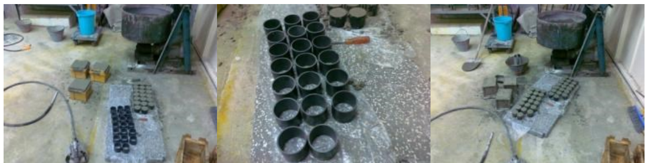
شکل ۱- ساخت فاصله نگهدارهای بتنی
