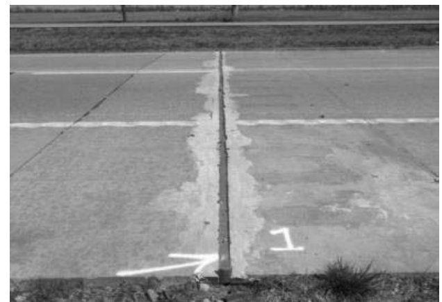
شکل ۱۳ - درز انبساط و اتصال [۱]
