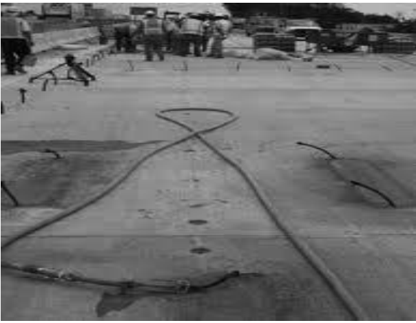
شکل ۱۴-ب- دوغاب ریزی داخل مجراهای پس کشیدگی [۱]
