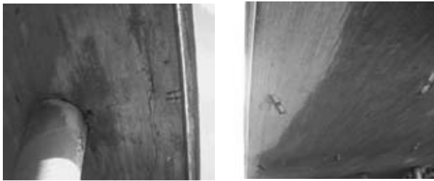
شکل ۲) نمونه‌ای از نشتی آب و خسارت مشاهده شده در سطح زیرین عرشه پل بتنی
