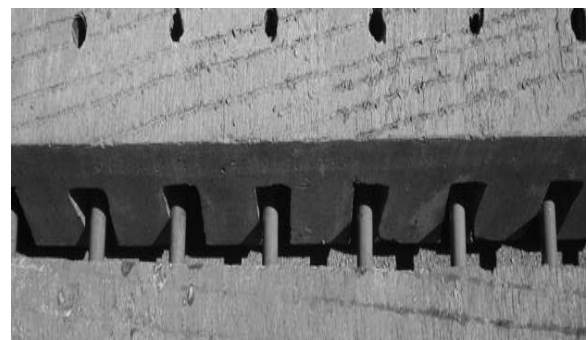
شکل ۱۱- آرماتورهای انتقال نیرو در جهت عرض جاده [۱]
