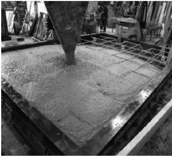
شکل ۹ - بتن ریزی پنل ها در کارگاه - بتن خود تراکم [۱]
