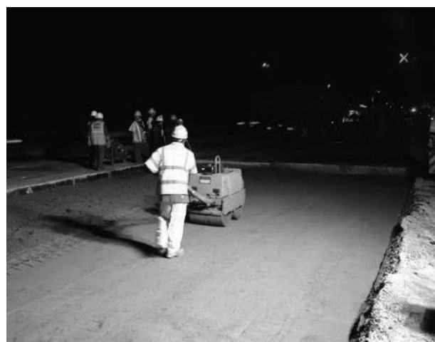
شکل ۱۰- الف بستر سازی سنگدانه ای
