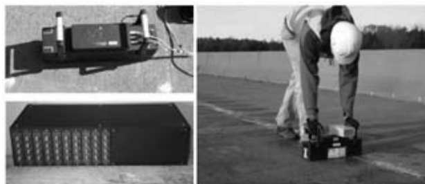
شکل ۶) ارزیابی عرشه یک پل با استفاده از دستگاه آلتراسونیک
