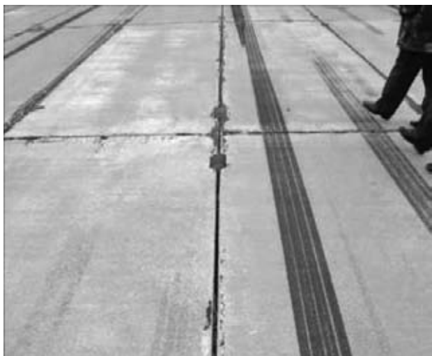
شکل ۱ - الف روسازی پیش ساخته اجرا شده در روسیه در دهه ۱۹۶۰ [۱]
