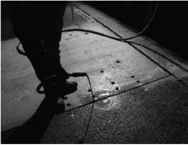
الف- دوغاب ریزی زیر پنل ها
