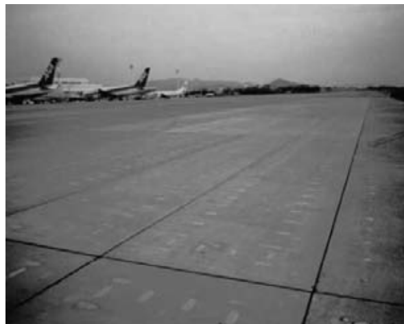
شکل ۲- استفاده از روسازی های پیش ساخته در فرودگاه [۱]
