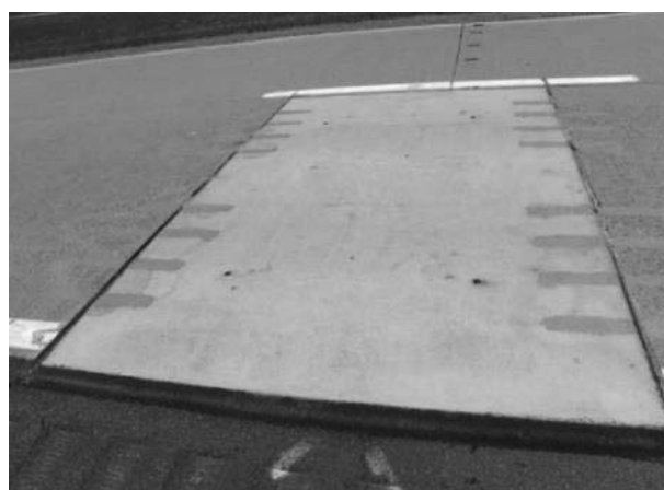
شکل ۳- نمونه ای از تعمیر روسازی به وسیله سیستم پیش ساخته (۲)، (۳)
