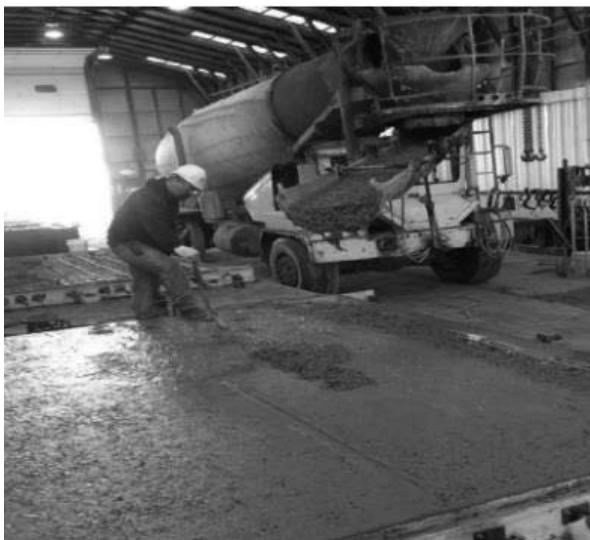
شکل ۹ - بتن ریزی پنل ها در کارگاه - بتن معمولی [۱]
