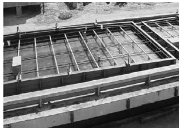
شکل ۸ - نمونه ای از پنل ها و سیستم مسلح سازی [۴]
