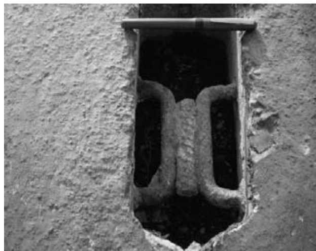
شکل ۱ ب اتصال جوشی متداول در روسازی های روسیه
