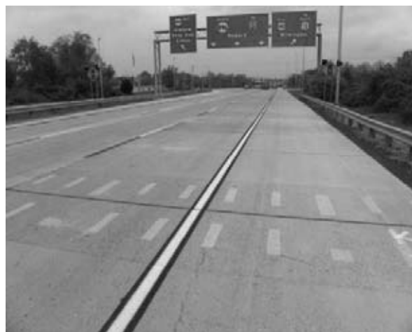
شکل ۳- استفاده از روسازی های پیش ساخته در بزرگراه [۱]
