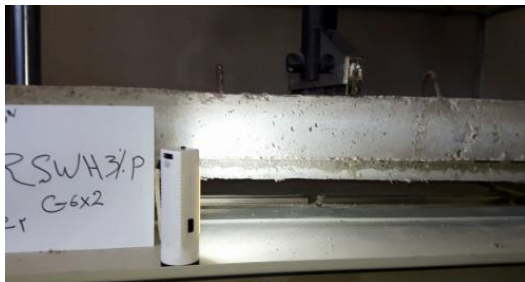
شکل (۱۰) گسترش ترک و افزایش ترک و پل زدن الیاف
