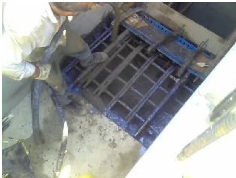
نمایی از بتن ریزی و دیواره های آغشته شده با دوغاب چسبی
