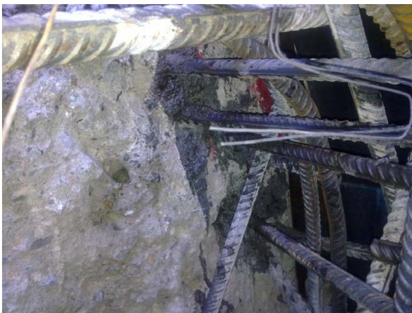
نمایی از کاشت میلگرد در دیواره ها جهت کاشت میلگردهای عرضی از بین رفته
