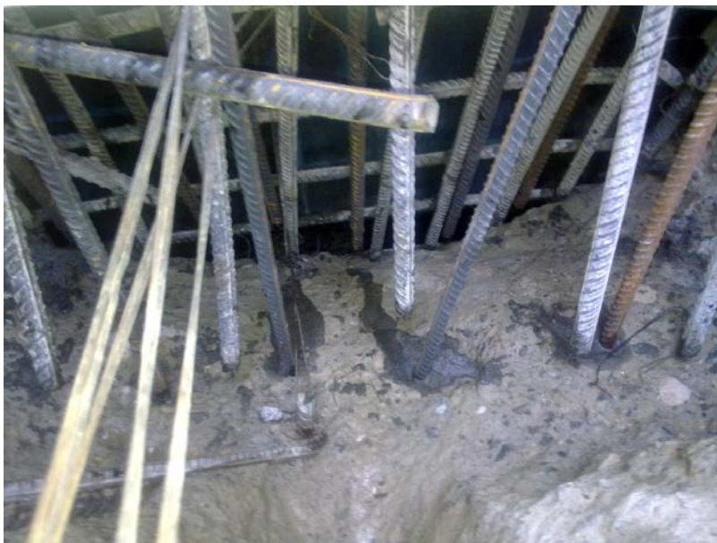
نمایی از کاشت میلگرد در کف جهت تقویت میلگردهای طولی
