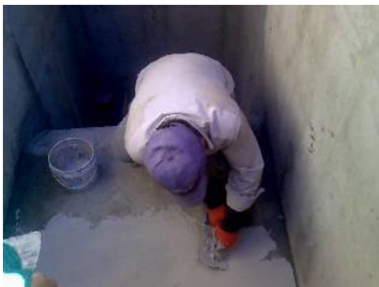
نمایی از عملیات لیسه کشی توسط بنای ماهر
