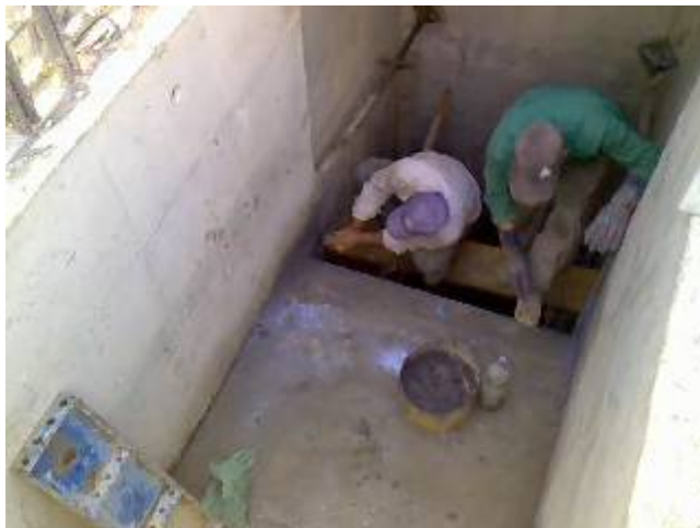
نمایی از ترمیم دیواره ها
