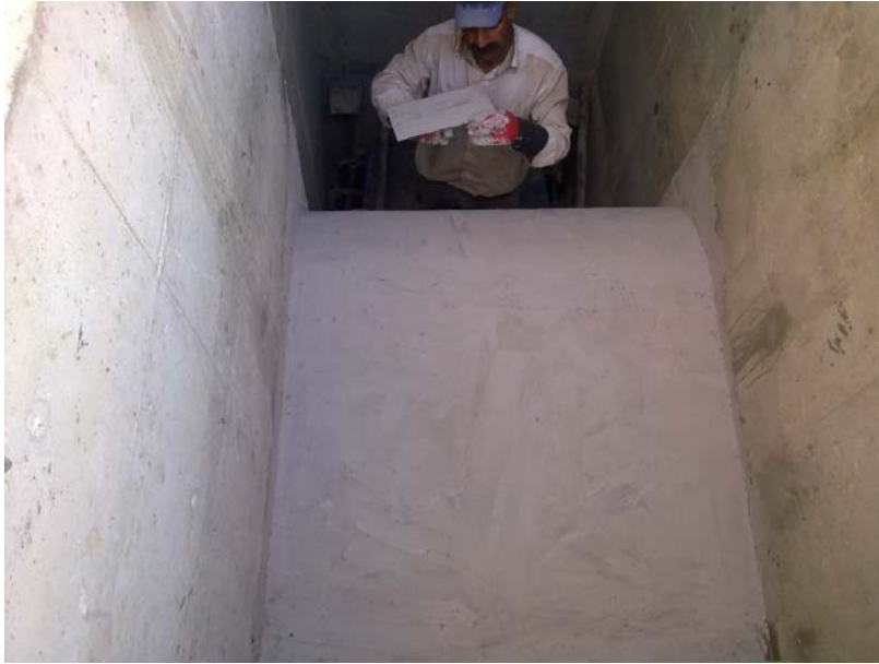
نمای دیگری از عملیات لیسسه کشی با ملات اپوکسی
