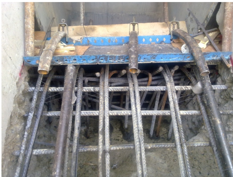
قالب بندی پس از کاشت میلگردها و تقویت میلگردهای طولی و تعبیه شابلونهای افقی
