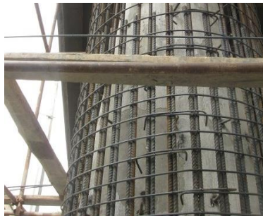
شکل ۹- ستون بتنی مقاومت‌سازی شده با ژاکت بتنی
