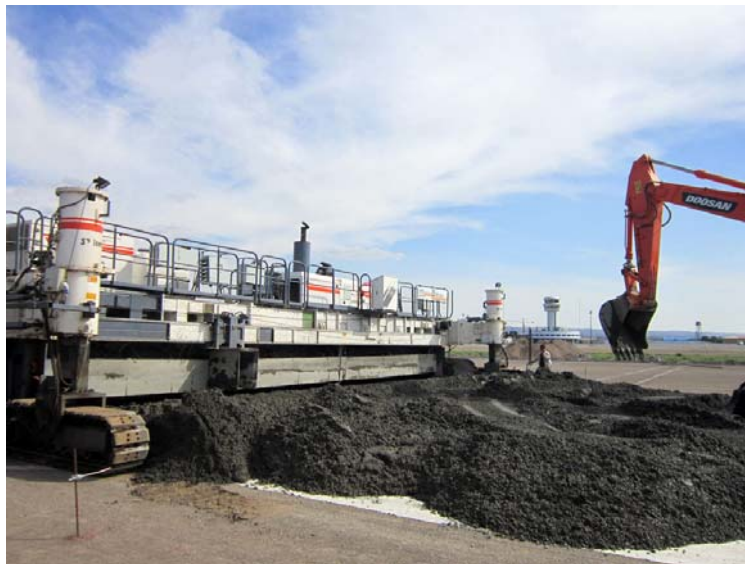
شکل ۲- بتن ریزی با دستگاه و قالب لغزان در فرودگاه تبریز
