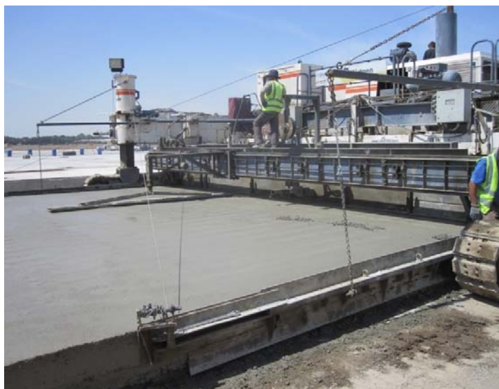
شکل ۱- بتن ریزی با دستگاه و قالب لغزان در فرودگاه مهر آباد
