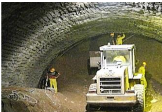
شکل ۸ - نمایی از عملیات اجرای بتن پاشیده
