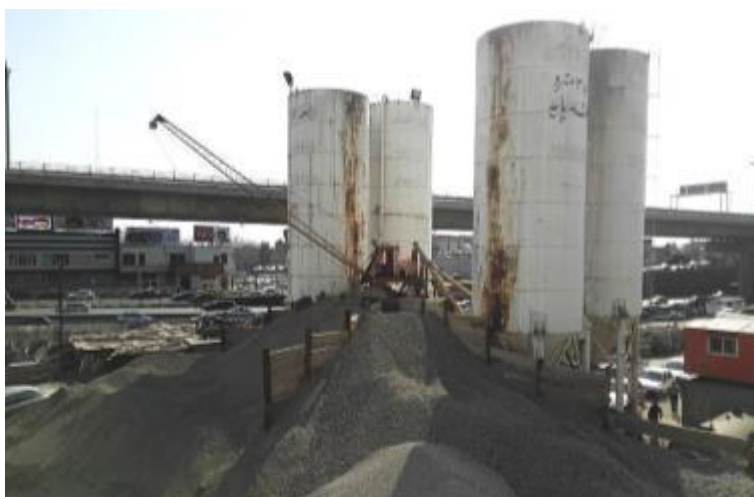
شکل ۷ نمایی از بچینگ پلانت مستقر در کارگاه ایستگاه صیاد شیرازی (۱۳۳)
