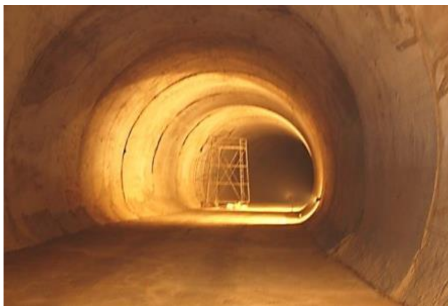
شکل ۱ نمایی از تونل احداث شده خط ۳ متروی تهران
