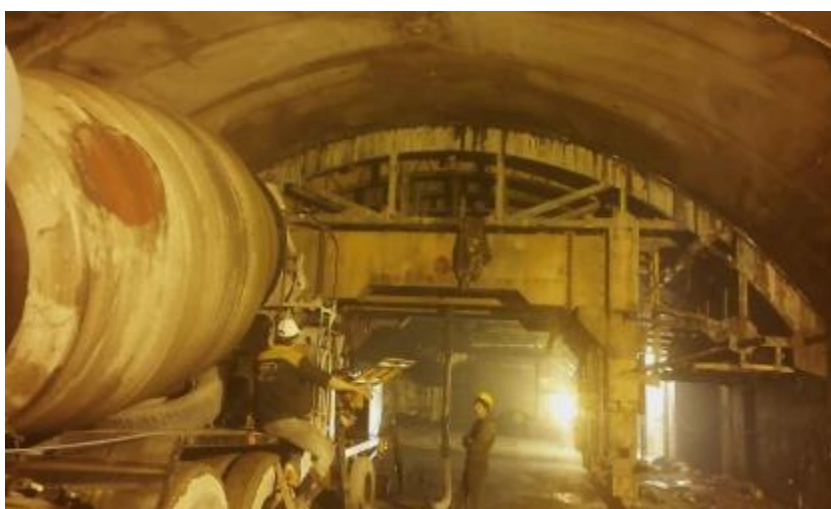
شکل ۶ نمایی از عملیات بتن‌ریزی
