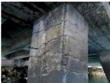
شکل (۸) : تخریب کامل (سمت راست) و تخریب قابل تعمیر (سمت چپ) اتصال سرشمع (شمع‌های بتنی) در اثر وقوع زلزله [۲۲]
