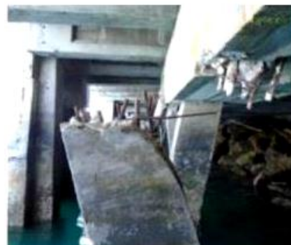
شکل (۸) : تخریب کامل (سمت راست) و تخریب قابل تعمیر (سمت چپ) اتصال سرشمع (شمع‌های بتنی) در اثر وقوع زلزله [۲۲]
