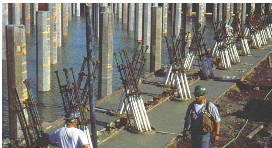
شکل (۱۱) : استفاده از اتصال فیوز کششی در شمع‌های مایل (پیش‌تنیده بتنی) [۲۵]
