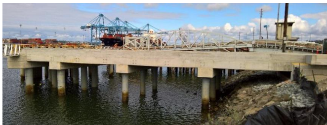
شکل (۱): نمونه‌ای از یک اسکله شمع و عرشه
