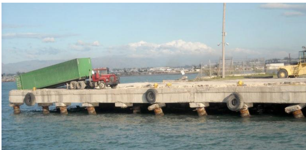
شکل (۵): تخریب کامل اتصالات سرشمع در اسکله شمع و عرشه (شمع‌های فولادی) در اثر زلزله [۲۲]
