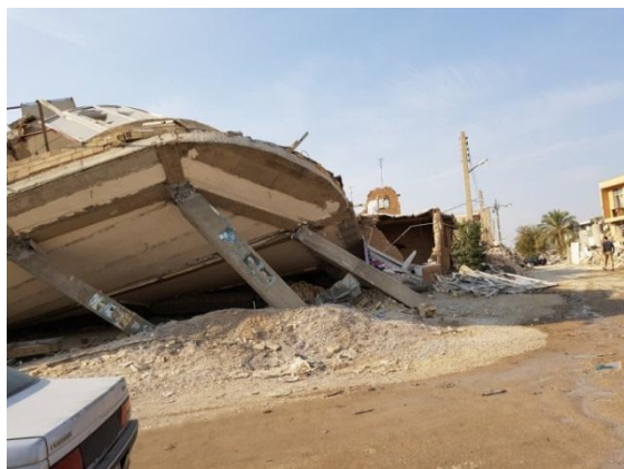
شکل ۱۸- ساختمان بتنی نوساز فروریخته در سرپل ذهاب
