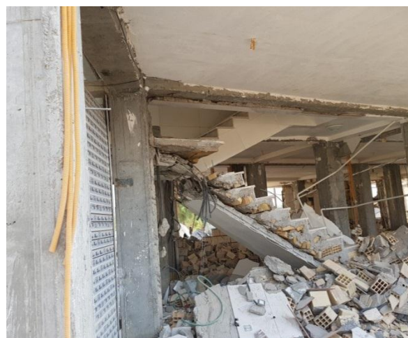
شکل ۲۰- ساختمان بتنی نوساز با تخریب شدید راه پله و عناصر غیر سازه‌ای در سرپل ذهاب
