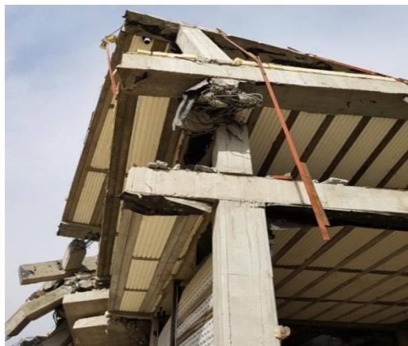
شکل ۱۱- ساختمان بتنی نیمه‌کاره فرو ریخته در اسلام‌آباد (الف)
