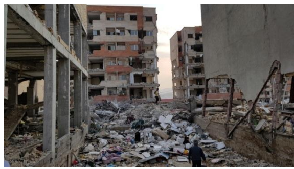
شکل ۱۰- تخریب گسترده در عناصر غیر سازه‌ای در ساختمان‌های اسکلت بتنی در مجموعه مسکن مهر شهید شیرودی در اسلام‌آباد غرب
