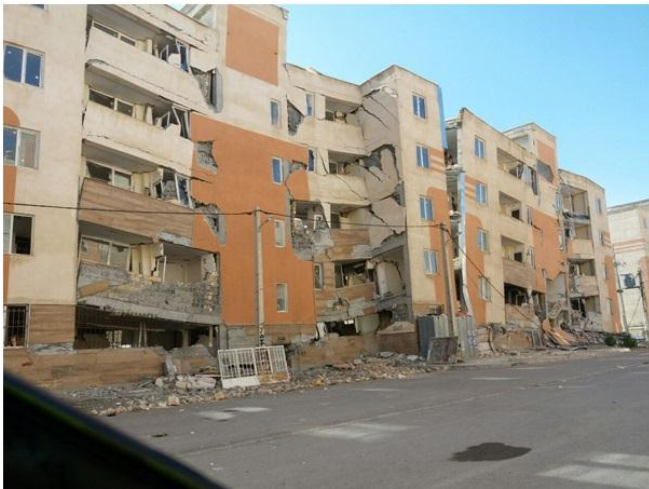
شکل ۸- تخریب دو بلوک بتنی در مجموعه مسکن مهر شرف آباد در اسلام آباد غرب
