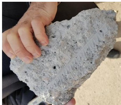
شکل ۱۳- عدم تراکم مناسب بتن در ساختمان بتنی نیمه‌کاره فرو ریخته در اسلام آباد (الف)
