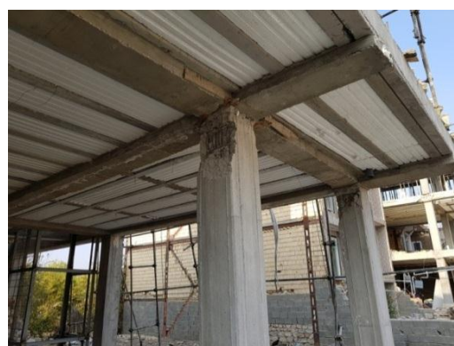
شکل ۱۷- ساختمان بتنی آسیب دیده در حال ساخت در سرپل ذهاب (ب)
