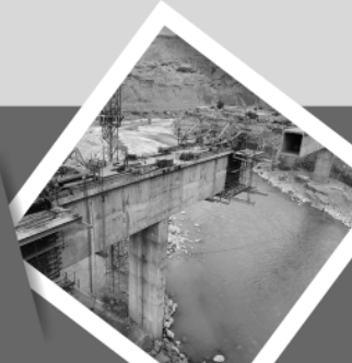
پل راه آهن تله زنگ
